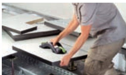
Per la posa di pavimenti di uffici e pannelli di laminato, la doppia ventosa è molto utile.
