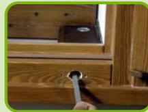
**Inserire** la barra quadra all'interno del meccanismo attraverso il telaio della finestra.
